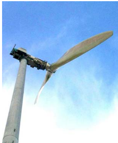
Rotor sous le vent (Vergnet 220 kW)
