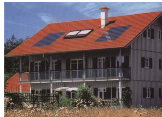
Toit solaire de 1,4 kW
